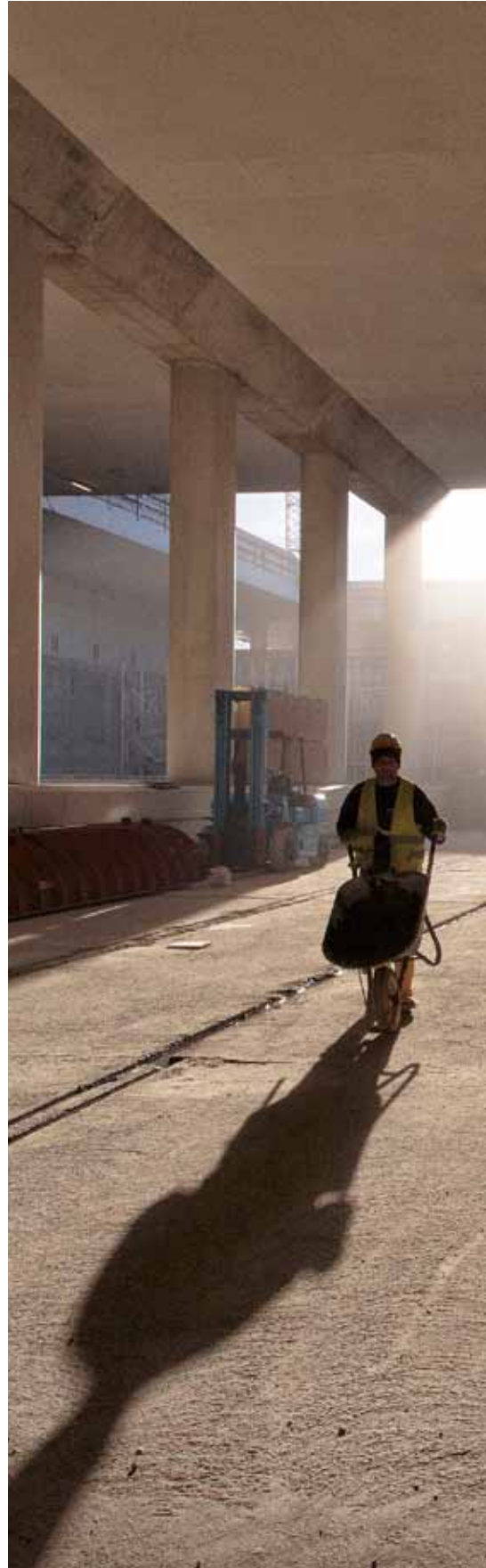
Ondergronds station in aanbouw
