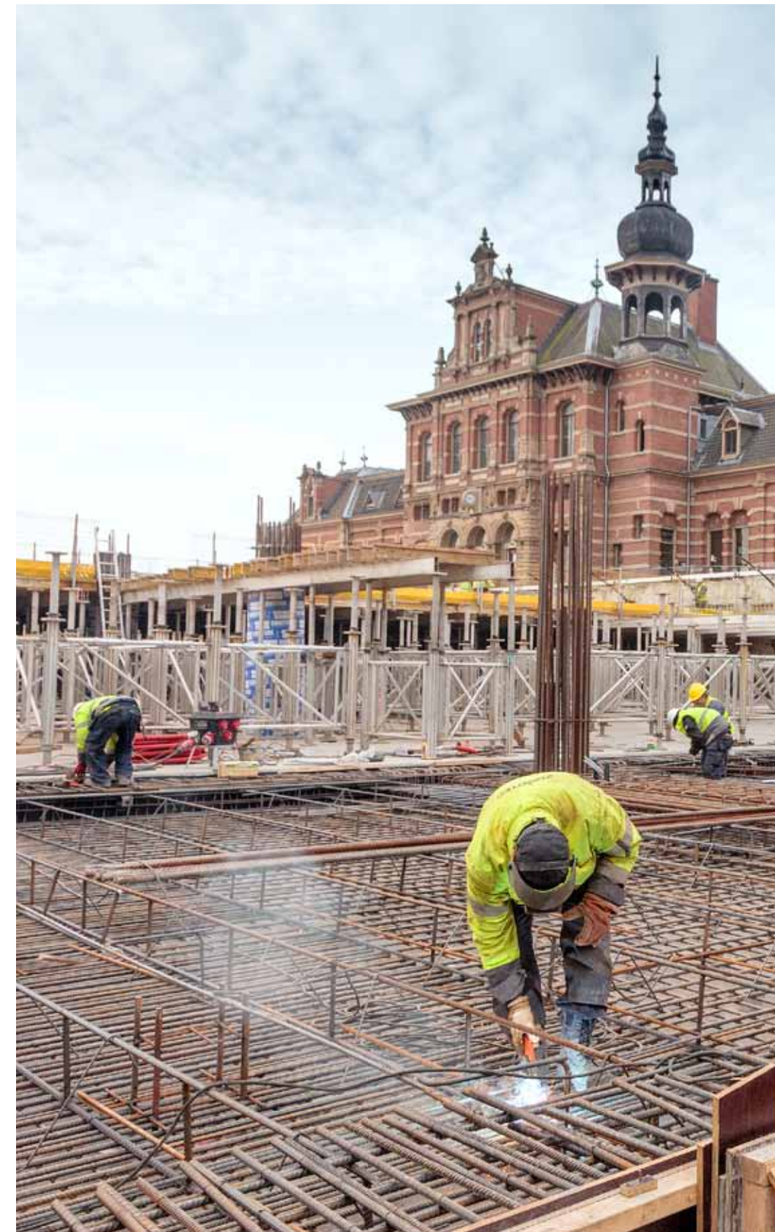
Ondergronds station in aanbouw met oud station op de achtergrond
